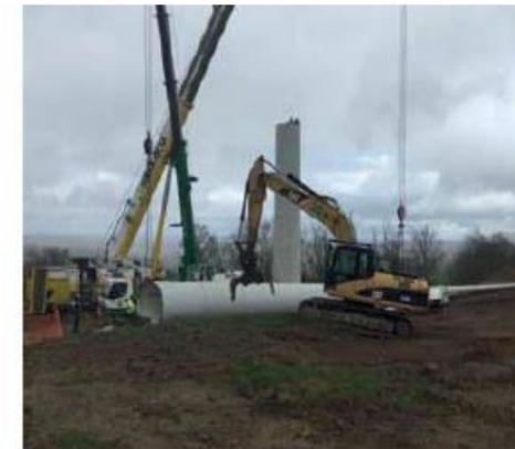
Photo 5 : Démontage d'un mât
