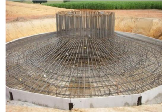
Photo 1 : Excavation et préparation de l'armature
